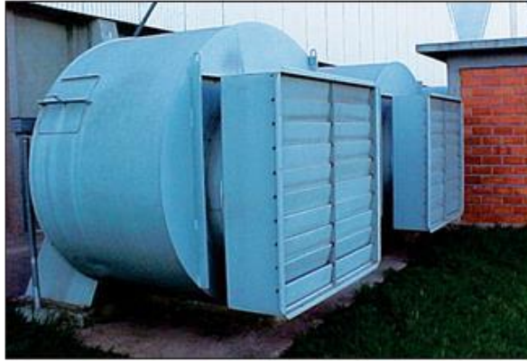
Figura 10: Ventilador ou exaustor
